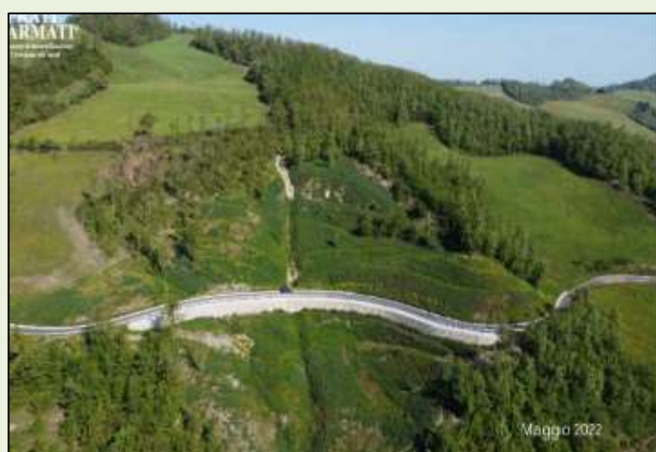
A1 Autostrada del Sole - Castiglione dei Pepoli: Blocco dell'erosione e sistema naturale di canalizzazione
